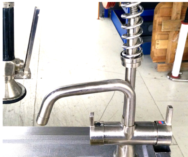
Spoeldouche kraan buiten gebruik
